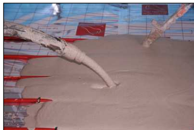
Díky příchytkám U80L se potrubí při betonáži a chůzi nevytahuje
