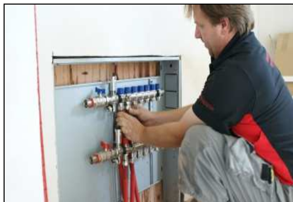
Snadná montáž potrubí k rozdělovací stanici pomocí Eurokonusů QUICK TH.
