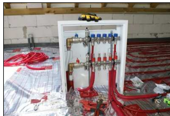
Montáž rozdělovací stanice „Na volno“ je připravena pro zabudování do sádkartonové příčky.
