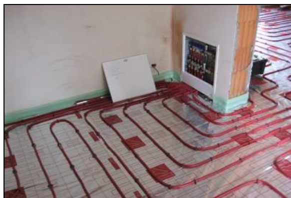
Rozdělovací stanici NEREZ s boxem lze zapustit do obvodové zdi.
