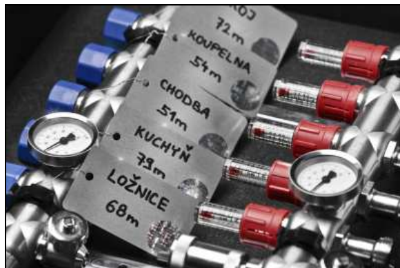
Snadná regulace místností podle popisu dílčích okruhů přímo v rozdělovací stanici.
