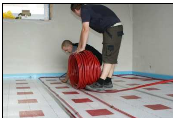
Montáž potrubí přímo na místě u zákazníka, podložka PROFI REFLEX 3000.
