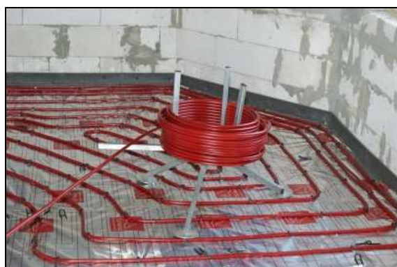
Instalace potrubí na podložku PROFI REFLEX 2000 za pomoci speciálního přípravku.
