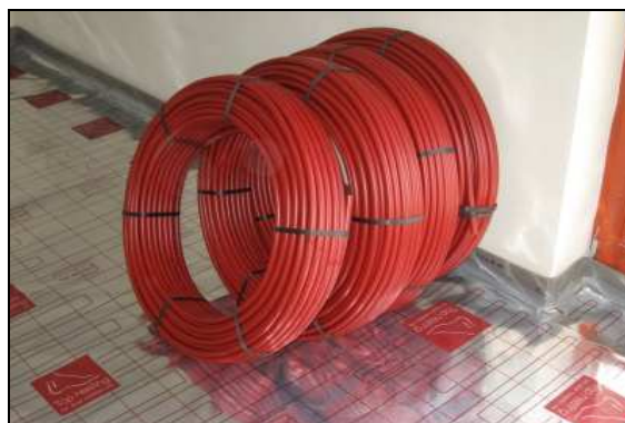
Návin potrubí Top heating po 200 m zajistí dostatečnou délku bez jeho nastavování.
