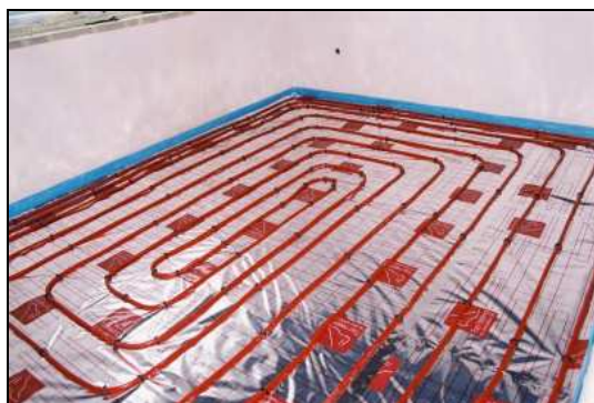
Reflexní podložka Top heating PROFI REFLEX 2000 po instalaci potrubí v místnostech novostaveb rodinných domů.
