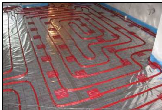
Reflexní podložka Top heating PROFI REFLEX 2000 po instalaci potrubí v místnostech novostaveb rodinných domů.
